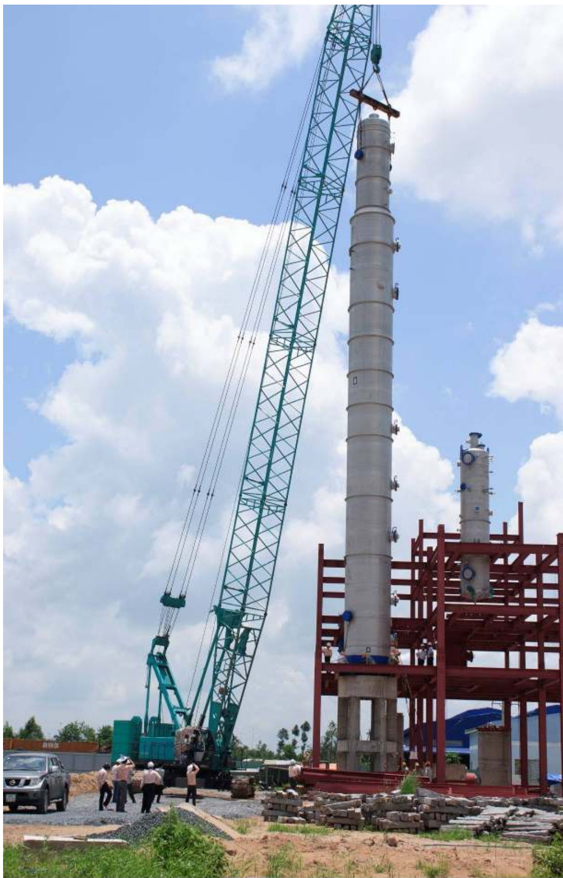
LẮP ĐẶT THIẾT BỊ GIAI ĐOẠN ĐẦU XÂY DỰNG NHÀ MÁY TÍNH LUYỆN DẦU CÀ
