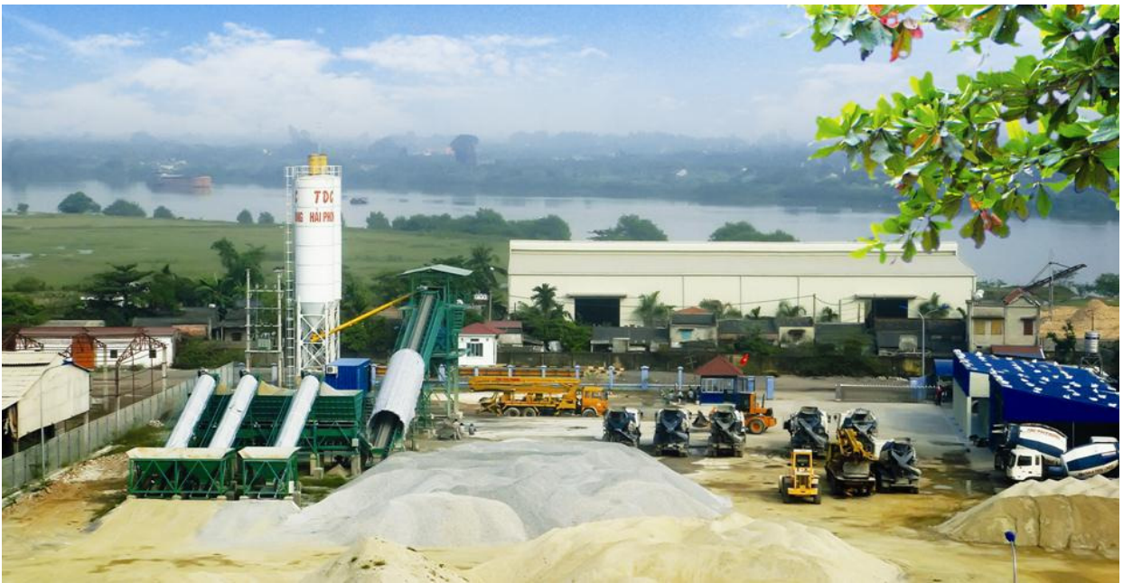
Góc nhìn trạm trộn bê tông TDC – Hải Phòng
